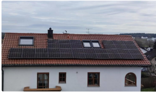
Aufdach-Montage Ziegeldach
