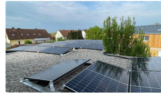
Aufständigung Flachdach
