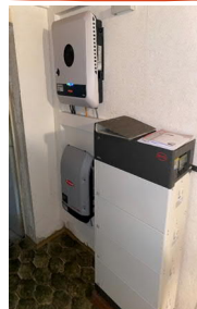
Zwei Wechselrichter + Speicher
